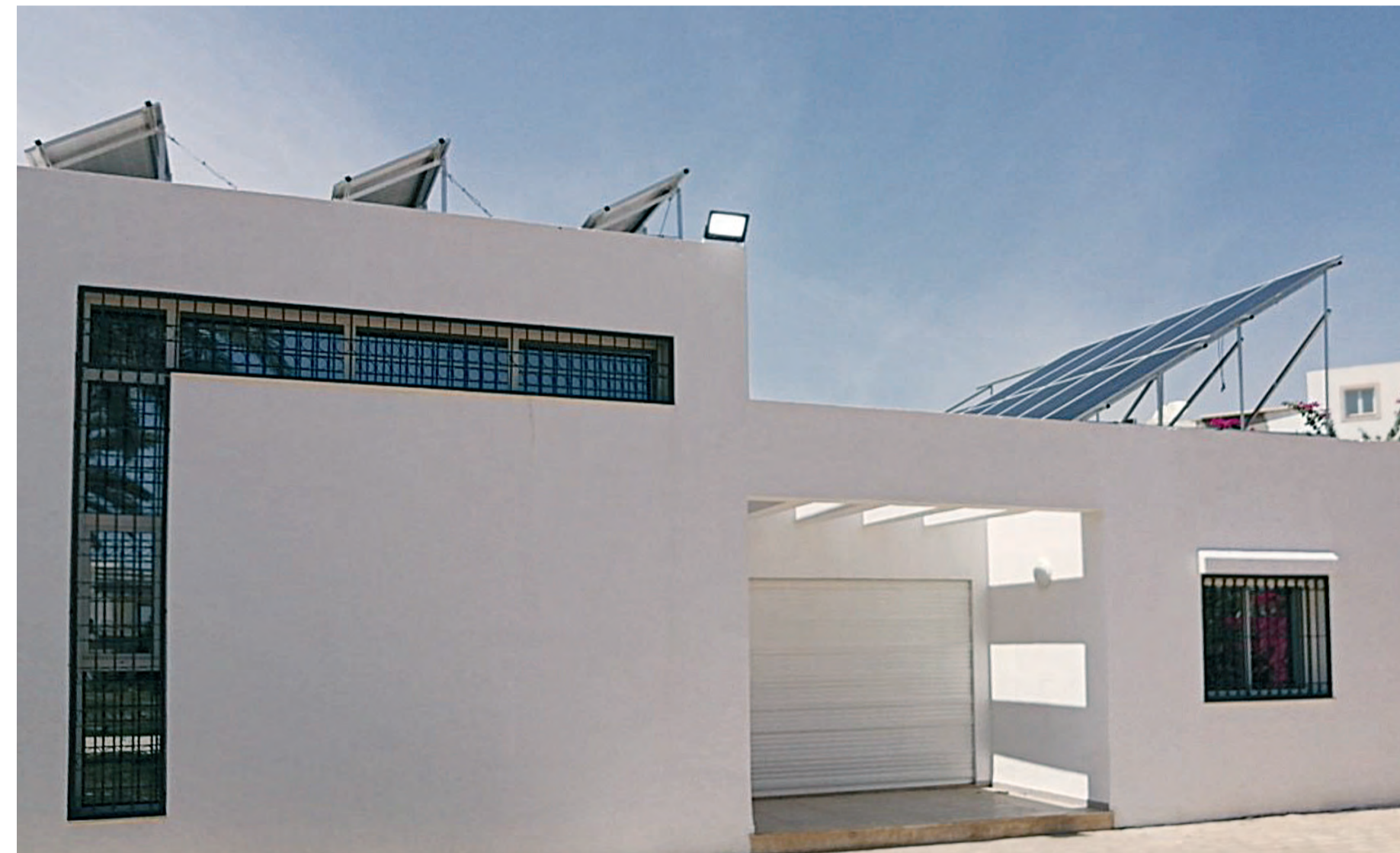
Toit solaire, bâtiment municipal - Hmadet Douik
